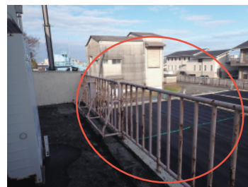
施工前（バルコニー柵）
