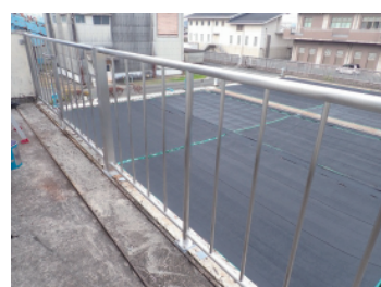
施工後（バルコニー柵）
