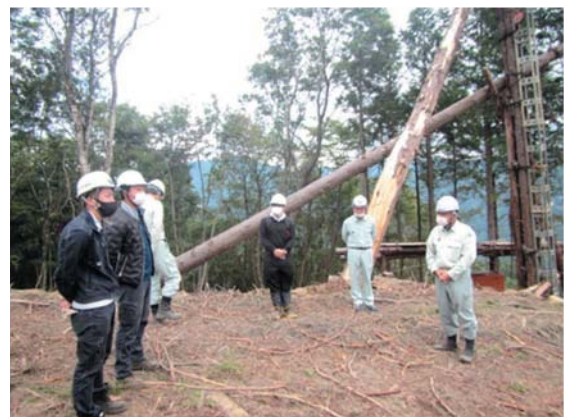
現場架線設置状況
