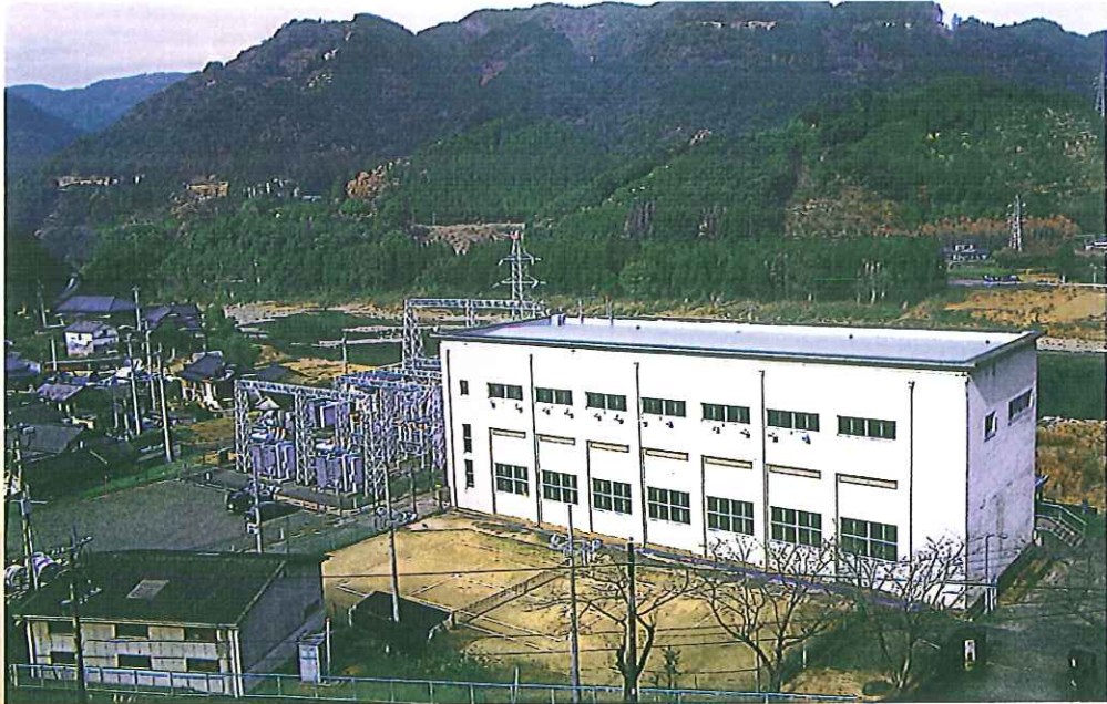
藤本発電所全景
