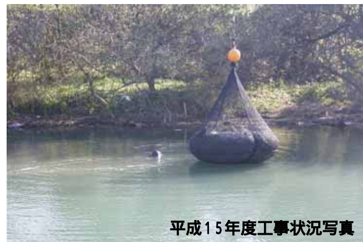
平成15年度工事状況写真
