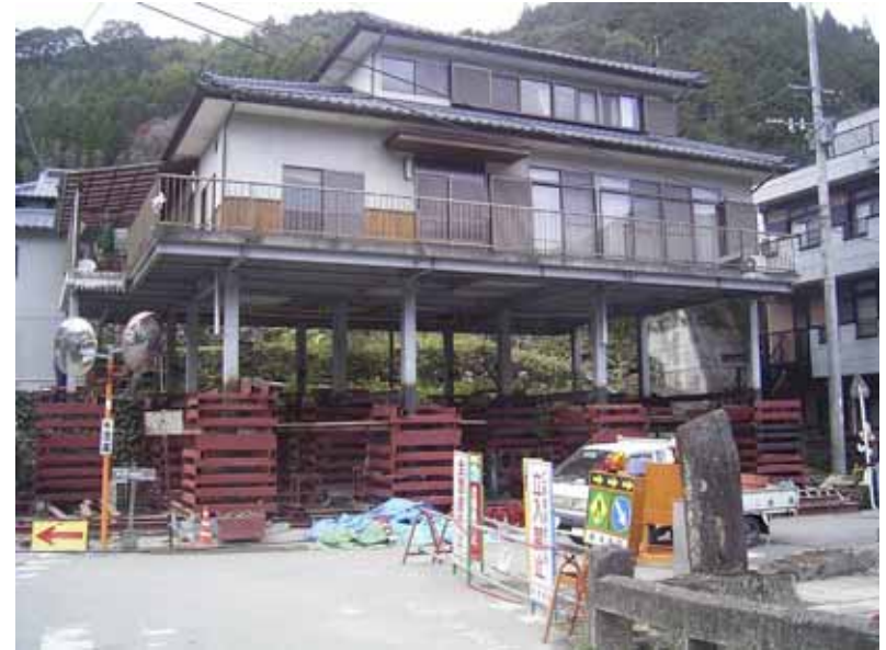
嵩上げ中の状況
