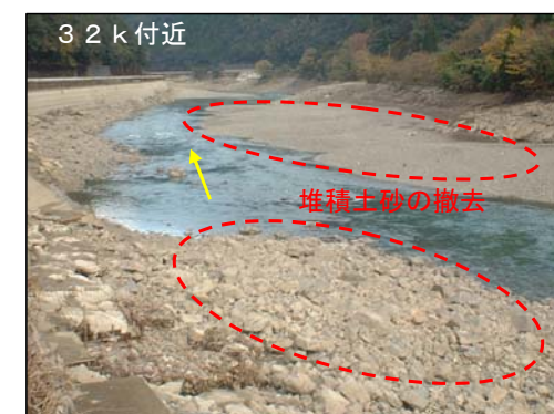
部分的な堆積土砂の除去
