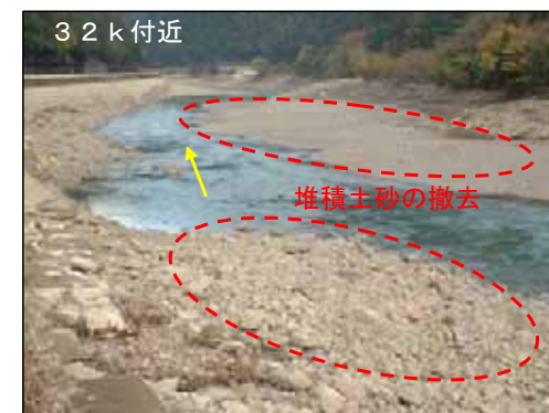
部分的な堆積土砂の除去
