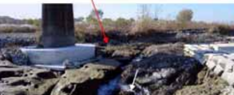
橋脚基礎部が洗掘された多摩川水系浅川の事例
