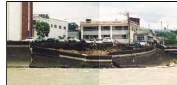
基礎洗掘により護岸が崩壊した球磨川の事例（山田川合流点（H8.7.3～8の出水後） ※軟岩の人吉層が洗掘された場合でも同様の崩壊が発生する可能性がある。
