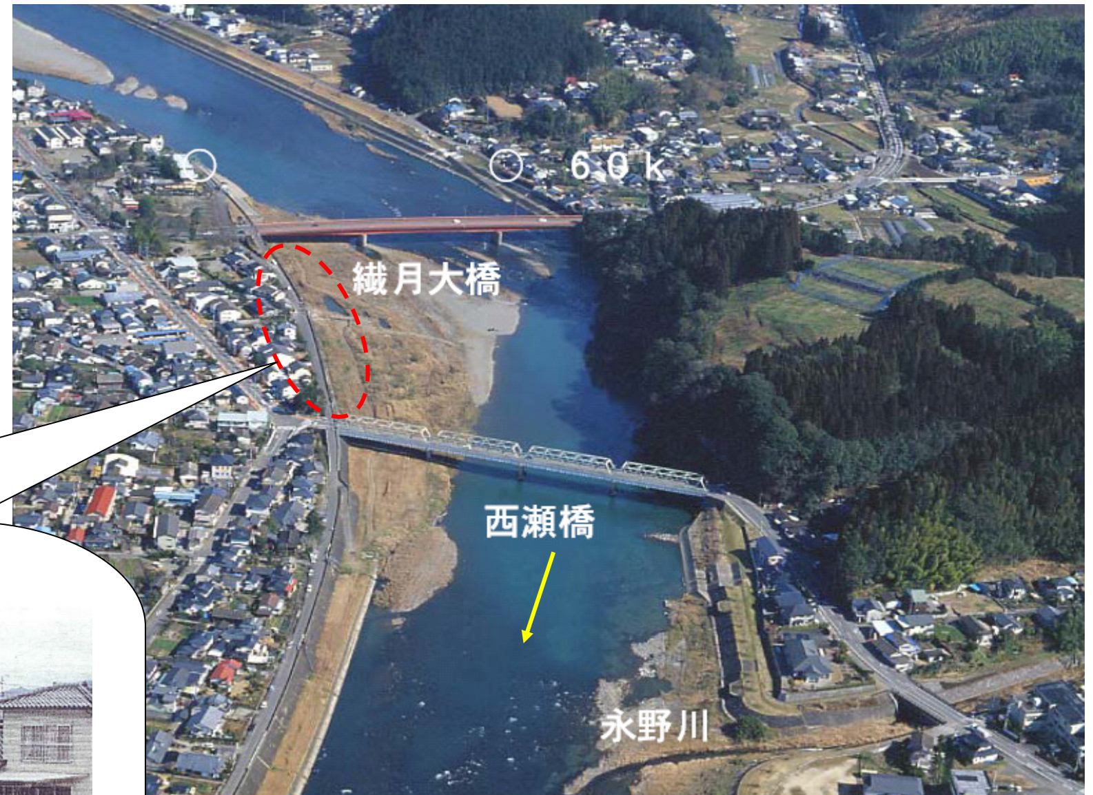
上薩摩瀬町付近の航空写真（平成17年2月撮影）
