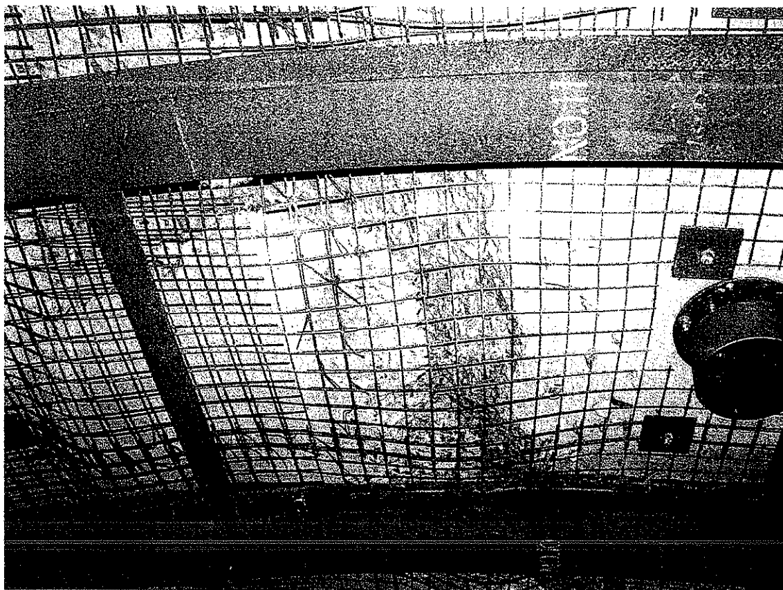
トンネル内部写真4 トンネル内部には各種センサーが取り付けられている。
