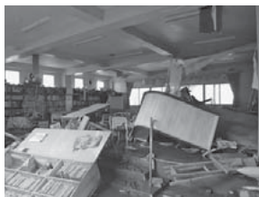
渡小学校の図書室被害
