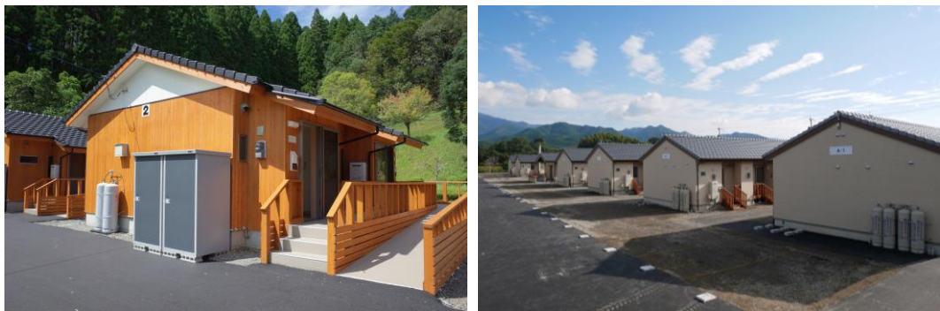
図 3-15 令和 2 年 7 月豪雨における木造仮設住宅
