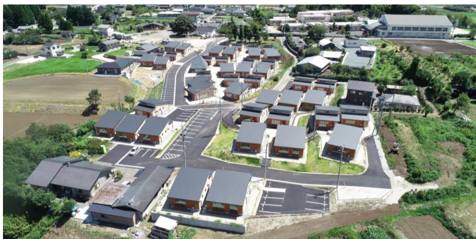
図 3-14 熊本地震における災害公営住宅（山西団地／西原村）
