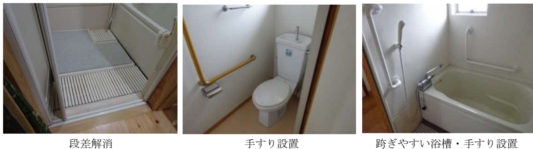
図 3-5 県営住宅におけるユニバーサルデザイン改修工事
