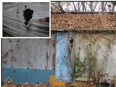
ロールカーテンの破損
