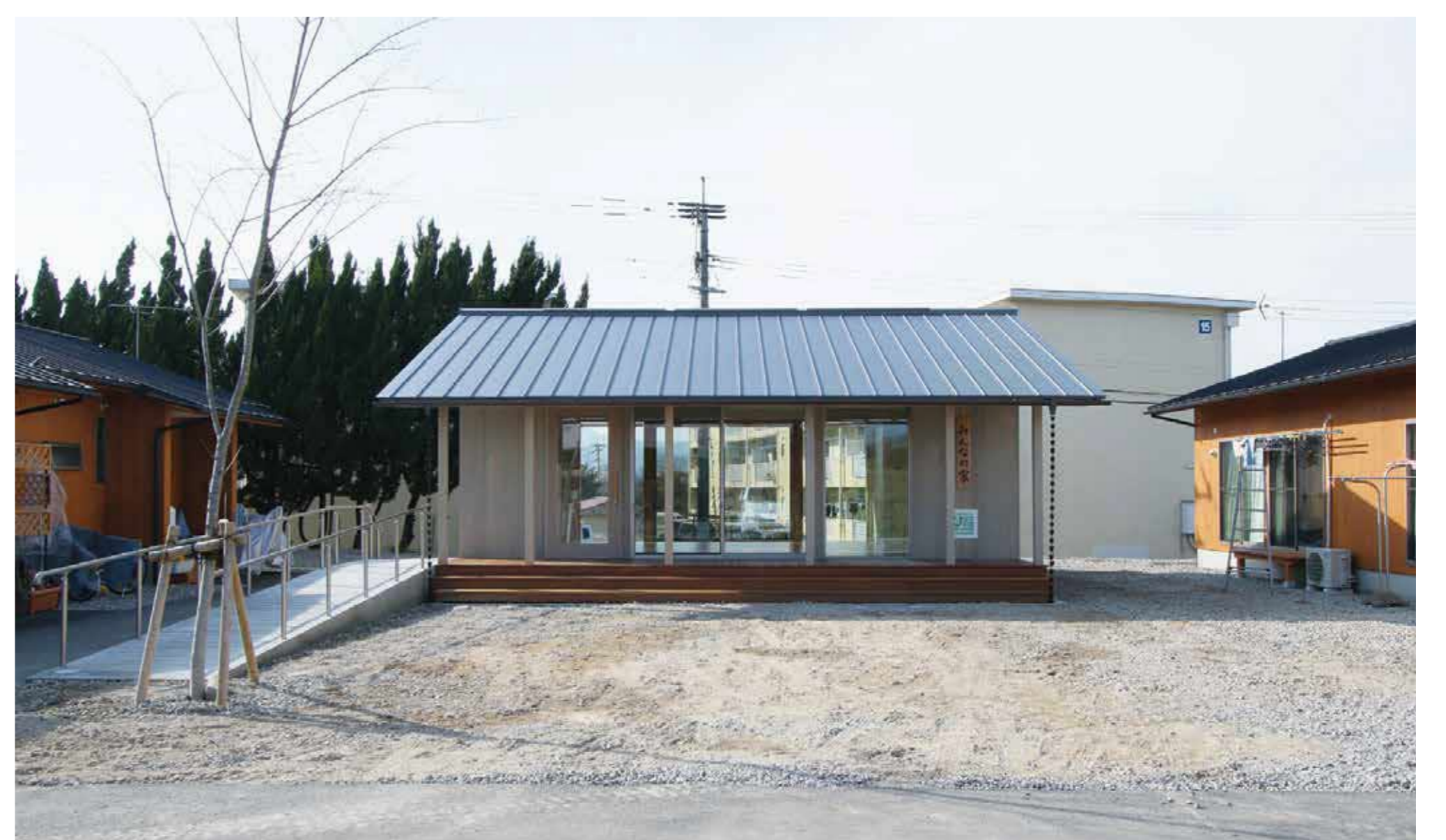
宇土市境目第3のみんなの家／広場に面したテラス空間
