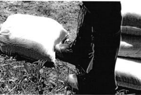
③ 足の幅程度(約30cm)に間を開け、補強用土のうを積みみます。
