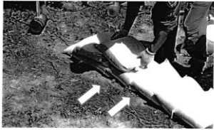
② 2段目は隣も同様土のうを重ね並べます。(講習会では3段積みにもしました) (矢印側からの水を防ぐ)
