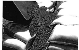
⑤ 土のうと土のうの間に火山灰を入れます。
