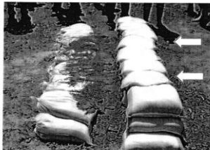
⑦ できあがりです。(矢印側からの水を防ぐ) 2重の壁にすることで、より強い土のうの壁ができます。
