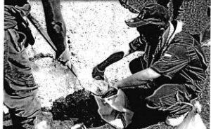
① 土のう袋をひろげ、スコップで4〜5杯の火山灰を入れます。 (48cm×60cm規格で7〜8割となり、重さは25kg〜30kgになります。)
