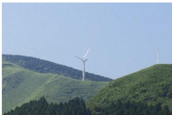
風力発電施設
