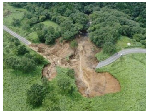
令和 2 年(2020 年)7 月豪雨災害により被災した草地(重要文化的景観)
