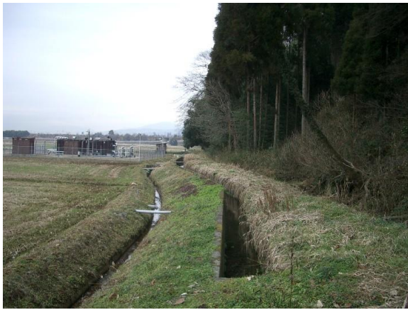
図 4 B地点全景
