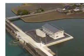
農業基盤整備（八代中央排水機場）
