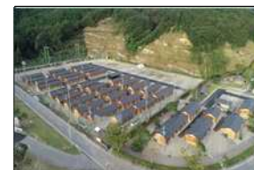
球磨村グラウンド仮設団地（R2年10月完成）
