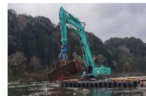
くま川鉄道の復旧（橋桁撤去）
