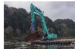
くま川鉄道の復旧（橋桁撤去）
