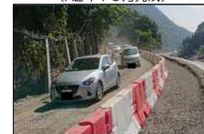
国道219号啓開完了（球磨村渡）
