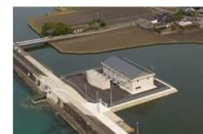
農業基盤整備（八代中央排水機場）
