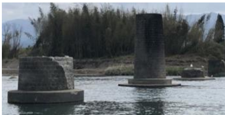
写真：流失した「球磨川第4橋梁（橋桁等）」の撤去完了
