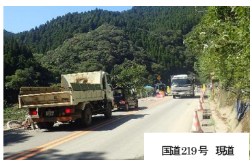
国道219号 現場 片側交互通行箇所の信号待ち状況
