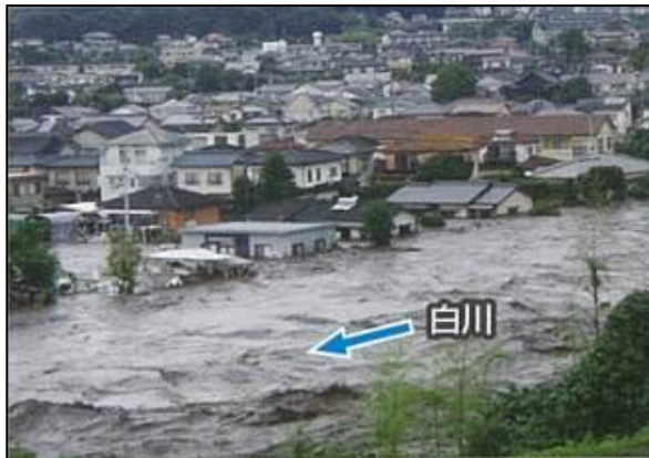
白川(県管理区間) :熊本市北区龍田1丁目
