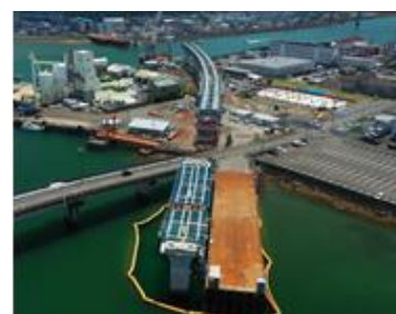
熊本天草幹線道路 本渡道路の整備状況（R3.8）
