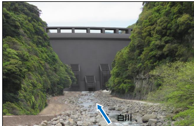
上流側からダムを望む
