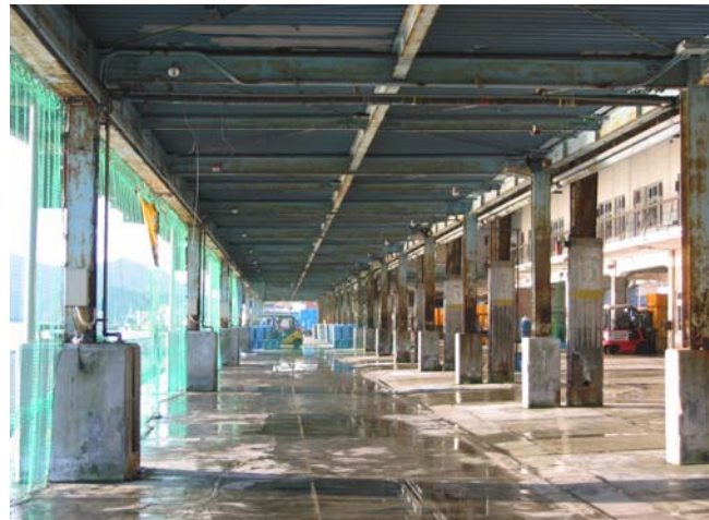
防鳥ネットを張り巡らせている
