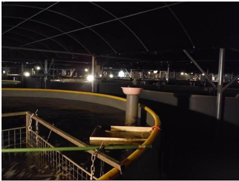
ウナギ養殖場内部（直径 8m の水槽が 36 基）
