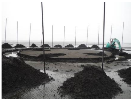
囲い網内の砂の部分掘り
