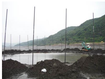
囲い網内の砂の全面掘り
