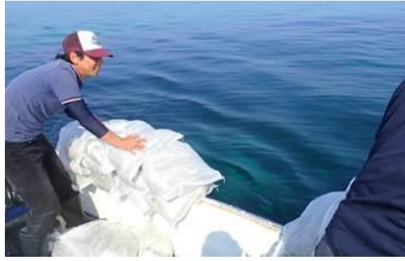
写真2 土のう投入作業（海中）
