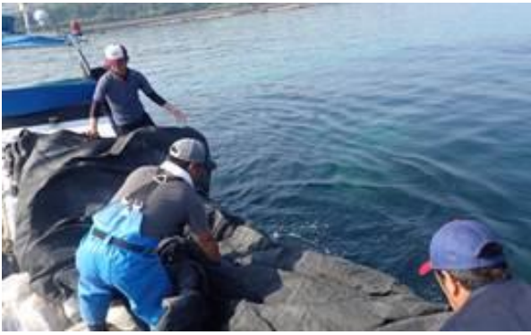
写真1 シート敷設作業
