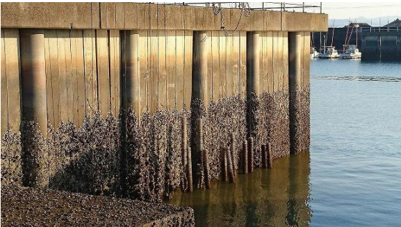
図5 クペル岸壁設置状況（鏡町、H29.1月）
