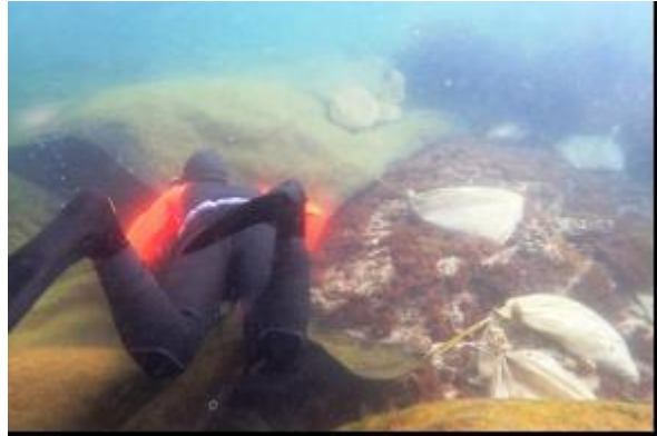
写真4 シート敷設作業 (海中)
