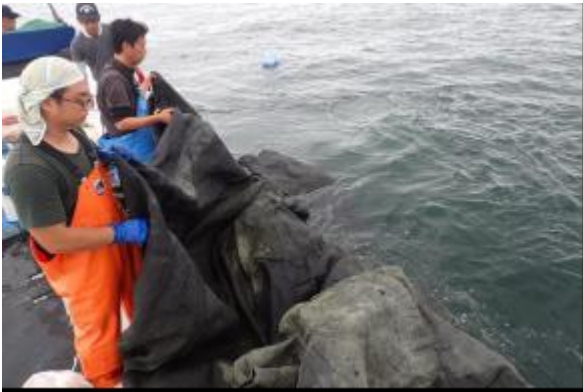
写真3 シート敷設作業 (海上)
