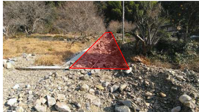
にごりけ 治山流路工の堆砂状況（濁毛地区） 地図番号:3
