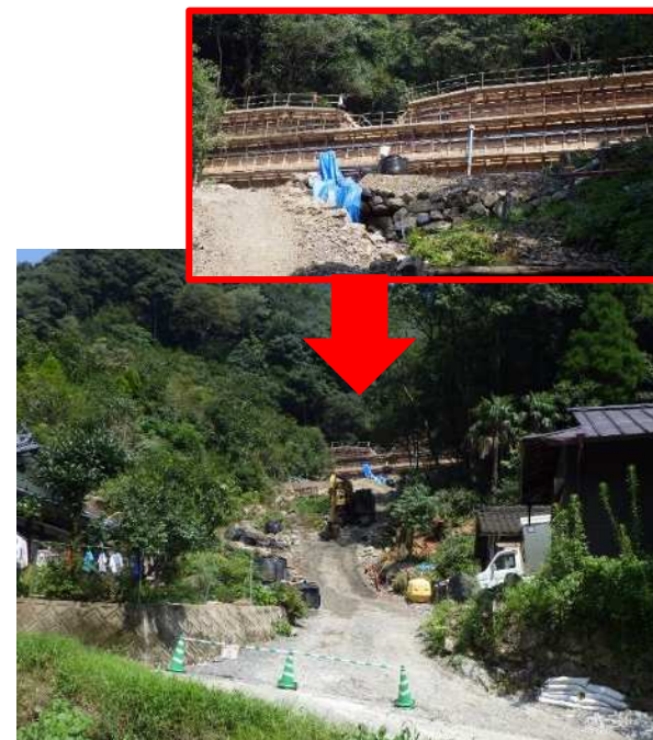
土石流が発生した溪流の復旧状況(谷止工の整備)
