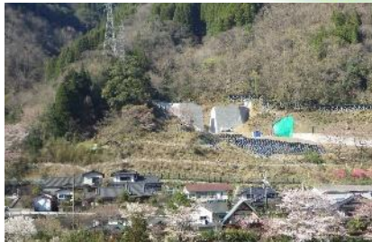
保全対象直上に砂防堰堤を整備
