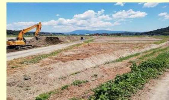
【農地堆積土撤去状況】
