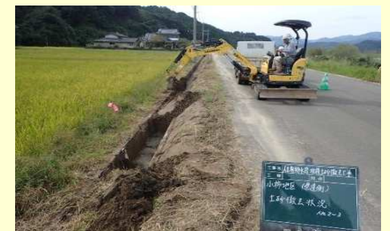
【水路堆積土撤去状況】
