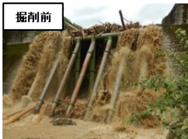
堆積土砂や流木の緊急撤去(牧良川(湯前町))
