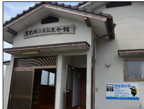
設置状況(多良木町)
