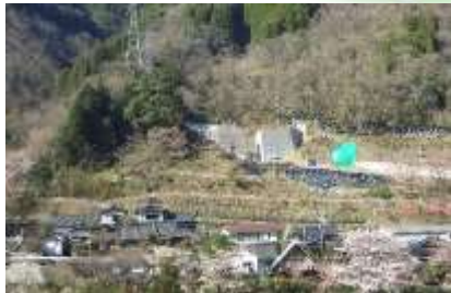
保全対象直上に砂防堰堤を整備
