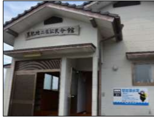
設置状況(多良木町)
