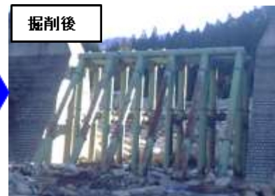
堆積土砂や流木の緊急撤去(牧良川(湯前町))
