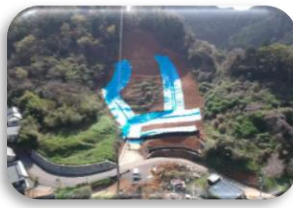
【⑤小田浦地区の応急工事】
