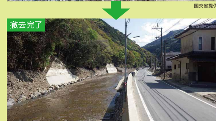
堆積土砂撤去(川内川・球磨村) 国交省提供
