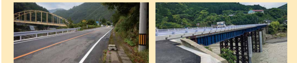
国道219号大野大橋付近(球磨村) 鎌瀬橋(八代市)
