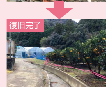
復旧完了 廃土による樹園地の復旧(芦北町)
