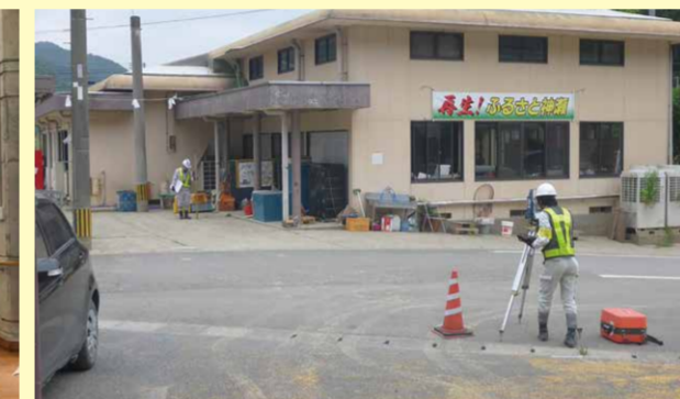
かさ上げ・遊水地等の検討に向けた測量の様子 国交省提供
