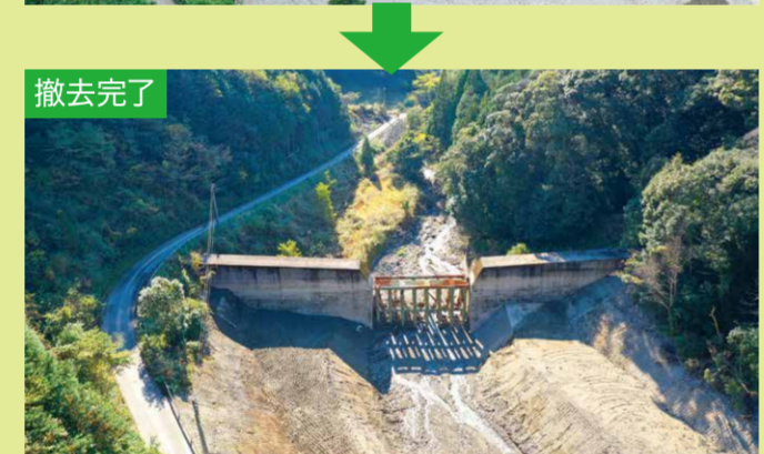
砂防堰堤の堆積土砂撤去(牧良川・湯前町) 国交省提供
