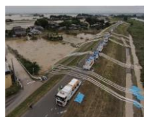
排水ポンプ車の排水状況事例
