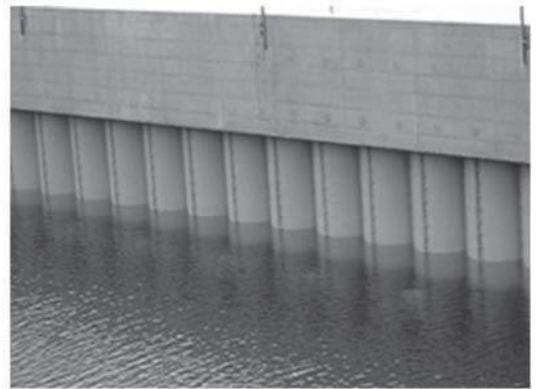
機能保全工事の実施 【竣工】
