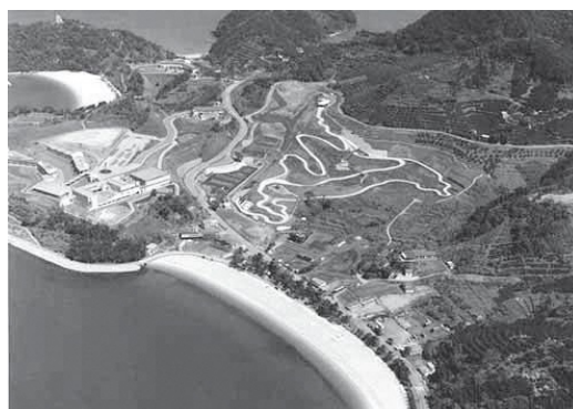
芦北海浜総合公園 <芦北海浜総合公園施設長寿命化事業>
