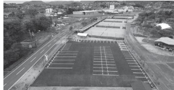
駐車場（テニスコート） ＜熊本県公園施設長寿命化対策支援事業＞
