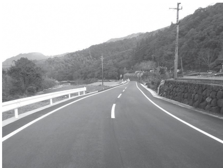
一般県道：越小場湯浦線（古石工区）R2 一部供用開始 <道路改良事業>
