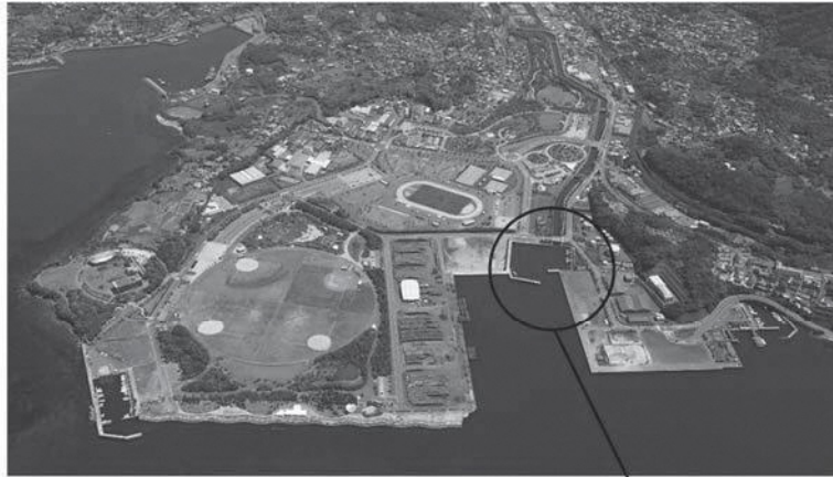
浮棧橋(現況写真)
