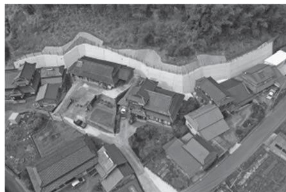
急傾斜地崩壊対策事業
