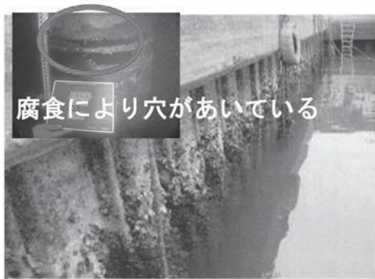
機能保全工事の実施 【着工前】
