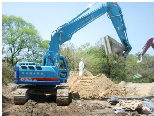
掘削などで使われる油圧ショベル
