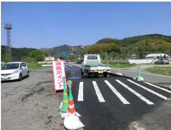
プール式消毒槽
