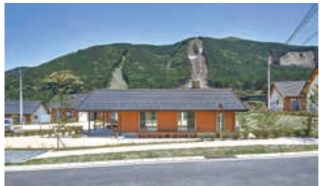
2016年4月の熊本地震は、熊本・阿蘇地域に甚大な爪痕を残したが当南阿蘇村買取型災害公営住宅馬立団地という創造的復興の第一歩となる作品を生み出した。棚田跡の緩い段差地形を活かした3地区に2戸1住戸が敷地に寄り添う配置、同地域の強い局所東風「まつぼり風」対策として南北方向に2戸をつなぐ通り土間を介した玄関口の配置、かつての集落の原風景を意識させる瓦葺の高い屋根と県産材を外観と室内に多用した温かみのある色彩、バリアフリーのスロープ、共有庭の設置、地域とのコミュニティーの円滑な形成のため広場と集会場を設置、北向山原始林を南面に臨む平屋住宅、3地区にまとめられた駐車場地下に雨水調整槽を設置するなど随所に限られた時間的・コスト的制約を克服しようとする南阿蘇村と設計・施工者の挑戦的な地域景観形成の意図と情熱を感じる。
