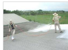
・石灰の吹きつけ
