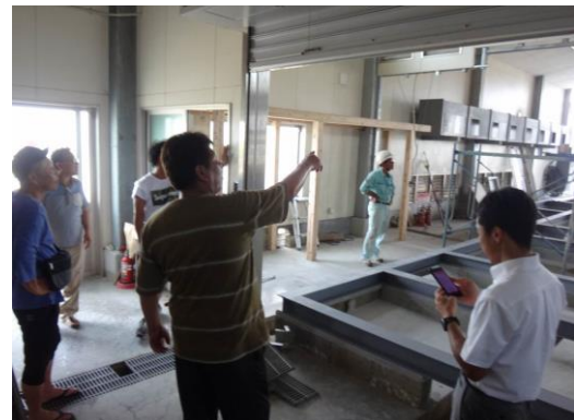
写真8 同左 (乾燥機交換状況)
