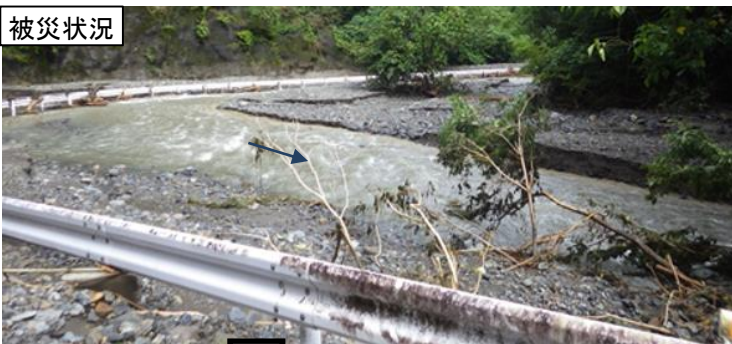
堆積土砂撤去(免田川・あさぎり町)
