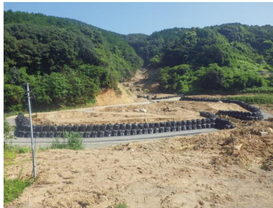
砂防堰堤応急対策(川内川・球磨村)
