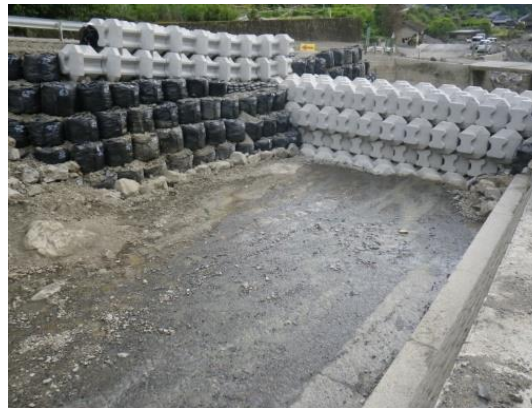
砂防堰堤応急対策(川内川・球磨村)
