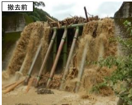
砂防堰堤の堆積土砂等撤去(牧良川・湯前町)
