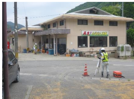
輪中堤・宅地かさ上げの設計・検討に向けた家屋敷高の測量状況 [球磨村]
