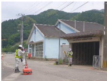
輪中堤・宅地かさ上げの設計・検討に向けた家屋敷高の測量状況 [球磨村]
