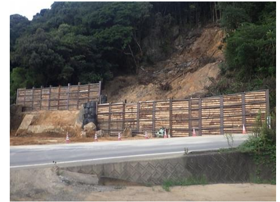
急傾斜施設応急対策(上村・芦北町)
