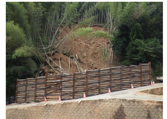
急傾斜施設応急対策(上村・芦北町)
