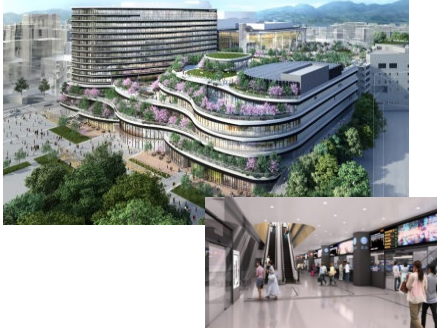
再開発による(仮称)熊本桜町バスターミナル整備
