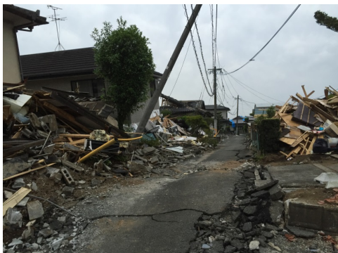
熊本地震による電柱の倒壊状況（益城町）
