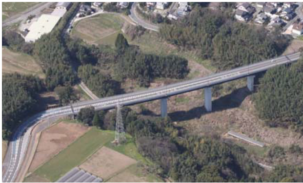
国道3号植木バイパスの整備状況
