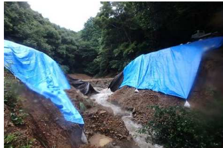
図 -2-(12) 芦北町兼丸迫ため池（緊急対策）
