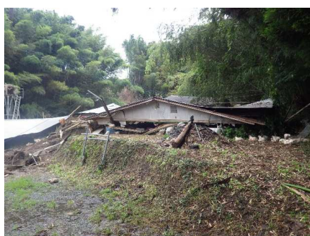
図 -2-(6) 鶏舎倒壊（南関町）
