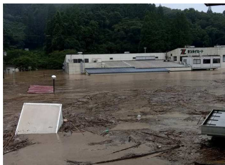
図 -2-(8) 人吉食肉センターの浸水状況【外観】（錦町）
