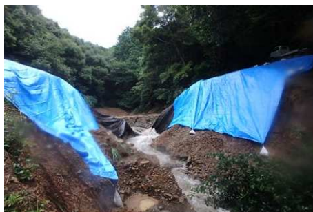
図 -2-(12) 芦北町兼丸迫ため池（緊急対策）
