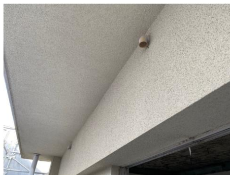
石綿含有仕上塗材(リシン)
