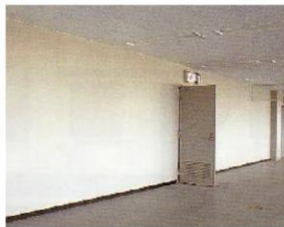
石綿含有けい酸カルシウム板 第1種(間仕切り)
