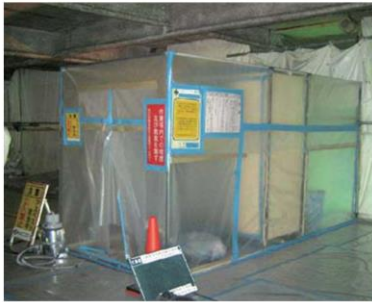
作業場の出入口に前室を設置
