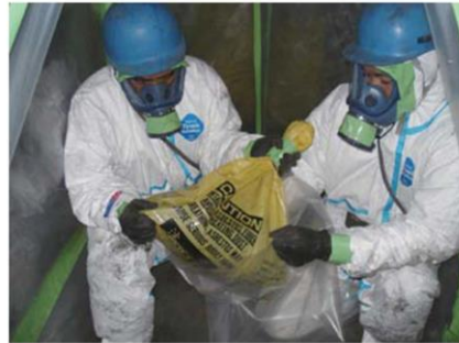
廃棄物(廃石綿)の二重梱包
