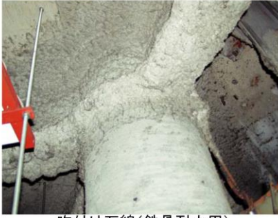
吹付け石綿(鉄骨耐火用)
