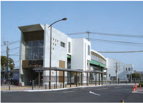
◎JR豊肥本線 光の森駅新設
