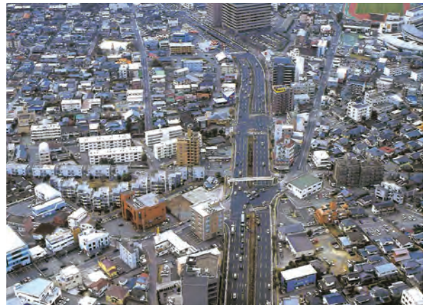
◎国道57号熊本東バイパス6車線化
