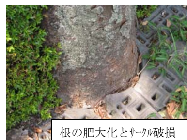
根の浮き・縁石押し出し
