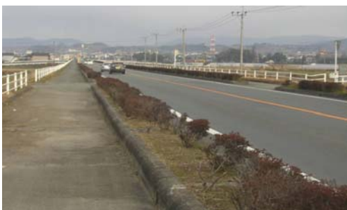
枯損部の放置
