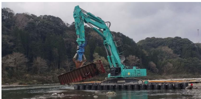
写真 : 流失した「球磨川第 4 橋梁」の撤去作業
