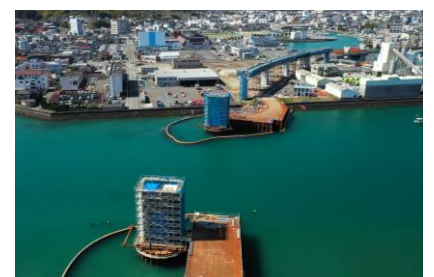
熊本天草幹線道路 本渡道路の整備状況 (R3.3)
