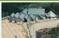
■ 熊本県賞 14 八代市立宮地東小学校 (施主／八代市)
