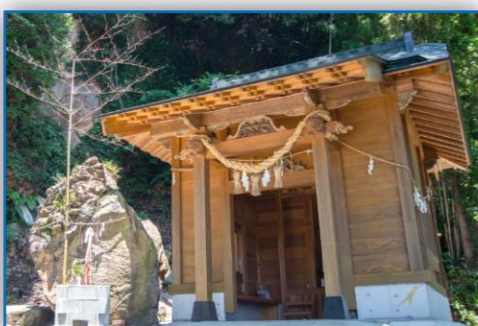
大津町：瀬田神社と巨石（震災遺構）
